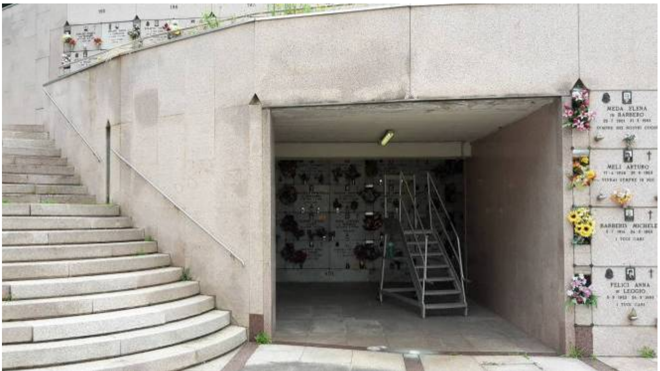
Foto 12 – sbarco della scalinata, adiacente ad un accesso alle gallerie
