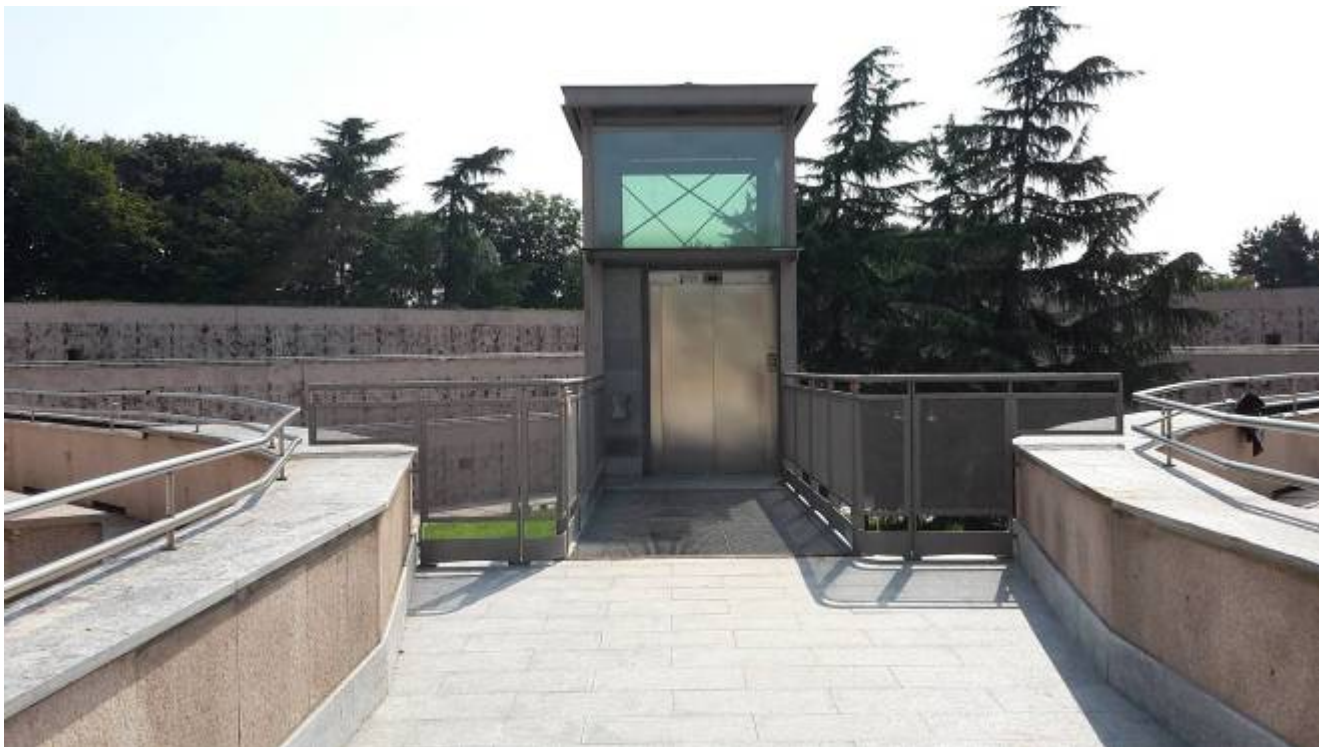
Foto 3 – vista ascensore esistente
