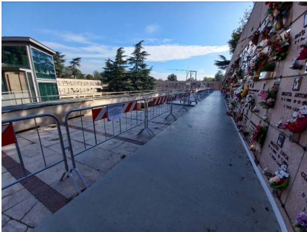
Foto 15 – vista balconata fronte 3, dettaglio pavimentazione sopraelevata provvisoria
