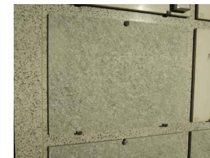
foto particolare aggancio inferiore e superiore
